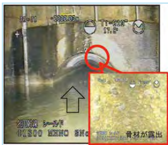
シールド工法で施工し老朽化が進む幹線
