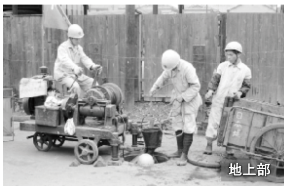
人力による下水道管の清掃作業の様子
