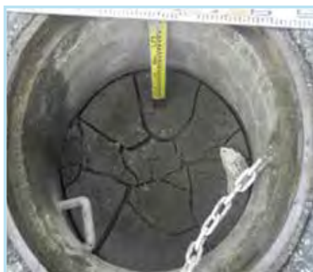
液状化により管路施設内に流入し、水締め効果により締め固まった土砂 (東日本大震災：平成 23 年)
