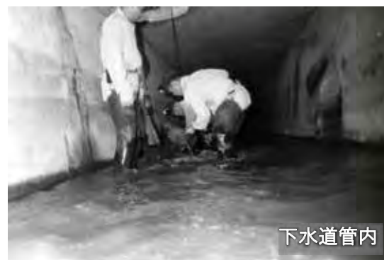
人力による下水道管の清掃作業の様子
