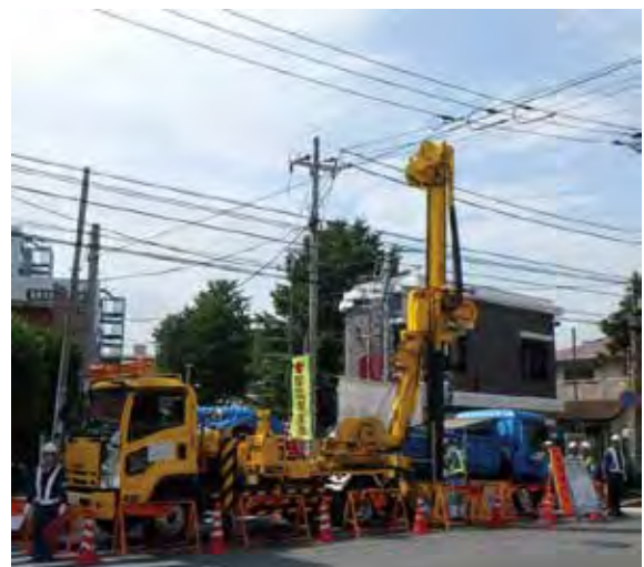
下水道施設伏越人孔内浚渫機による作業の様子
