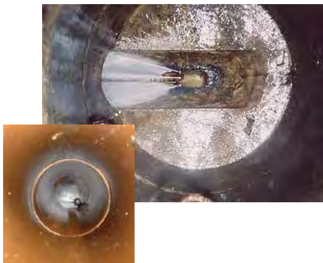
下水道管の高圧洗浄の様子
