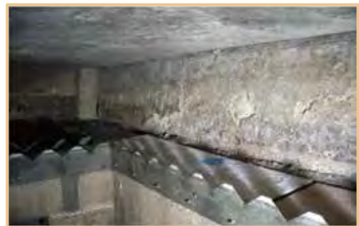
腐食したコンクリート施設(第一沈殿池)
