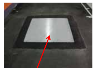
地上面と面一になるように地中に コイルを埋め込む
